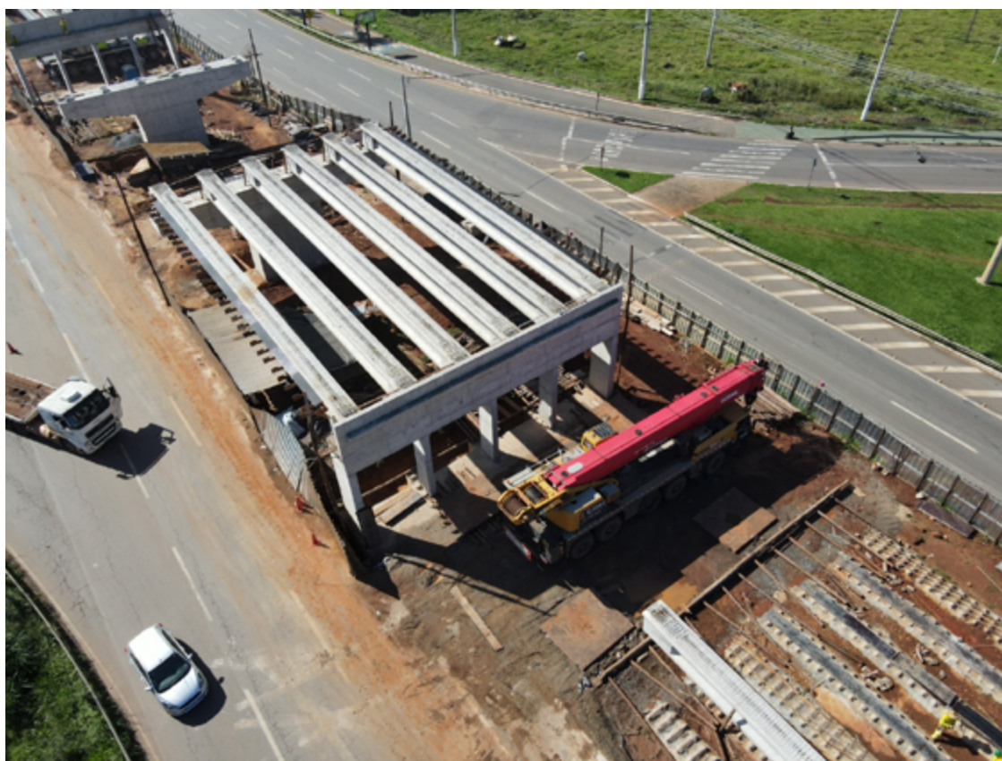
Obras do Viaduto Portal da Fé receberam a instalação de 18 vigas de sustentação
